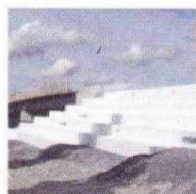
Remblais légers (Géofom)
